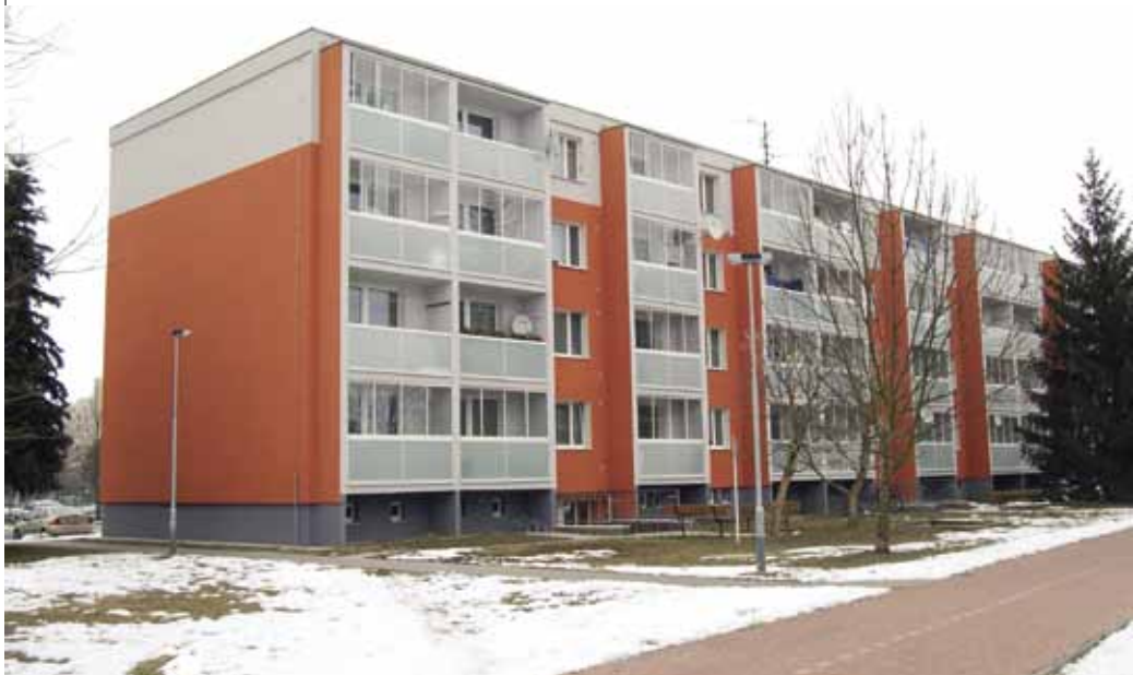
OSBD Olomouc- příklad modernizace panelových domů
